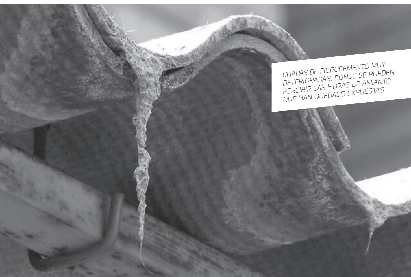
CHAPAS DE FIBROCEMENTO MUY DETERIORADAS, DONDE SE PUEDEN PERCIBIR LAS FIBRAS DE AMIANTO QUE HAN QUEDADO EXPUESTAS
